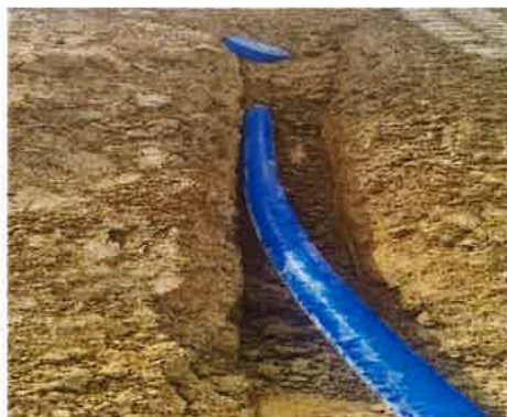
Slika 12: rekonstrukcija cevovoda Lenart – Jurovski Dol
