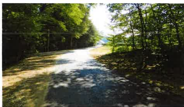
Slika 6: Izgradnja ceste JP 703 316
