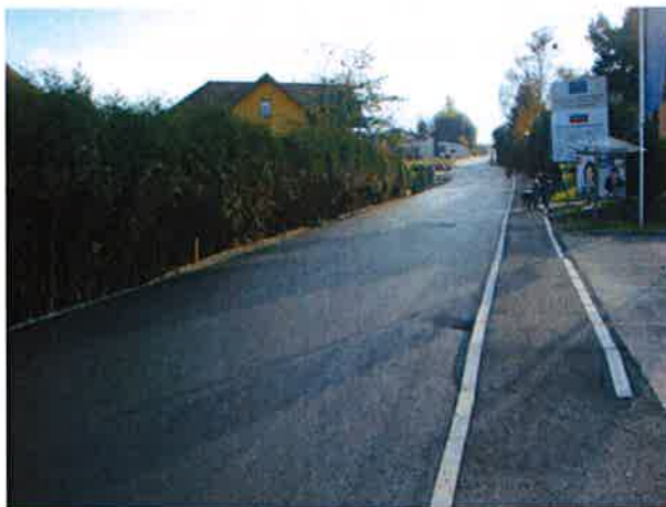
Prometna povezava urbanega središča z avtocesto (foto: arhiv občine)
