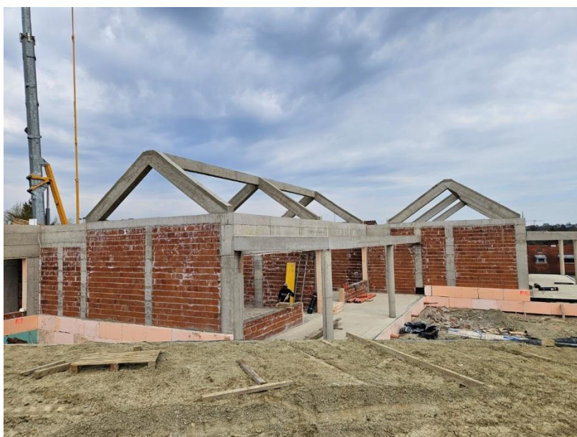
Slika 26: Vrtec v izgradnji
