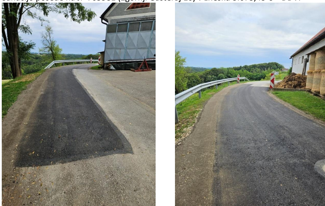
Slika 9: Sanacija posede na JP 705 581 - Zg .Gasteraj 10
