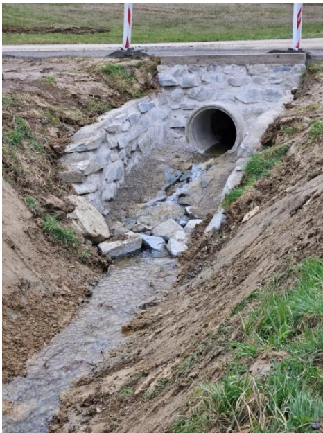
Slika 13: dela pod mostom na JP 703 321
