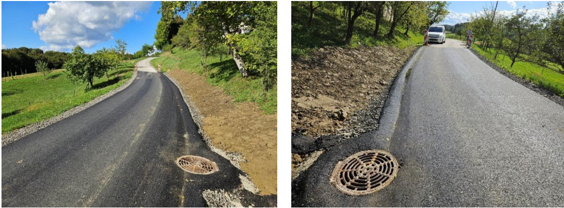
Slika 12: sanacija in asfaltiranje plazu v Sp. Gasteraju
