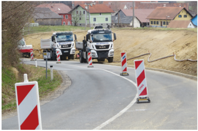
Dela pri modernizaciji ceste in izgradnji pločnika ter javne razsvetljave skozi Spodnjo Senarsko so v polnem teku.
