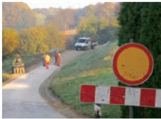
Občina Cerkevjak je letos rekonstruirala 420 metrov ceste Vanetina–Brengova, naslednje leto pa bo modernizirala še 600 metrov te ceste.
