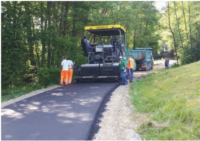
Asfaltiranje cestnega odseka Zaletinger v Sr. Gasteraju je potekalo minuli teden
