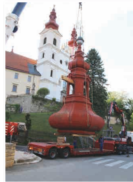
Polaganje strehe zvonika na specialno prikolico
