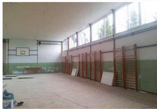
Največji poudarek energetske sanacije OŠ J. Hudalesa je na telovadnici.
