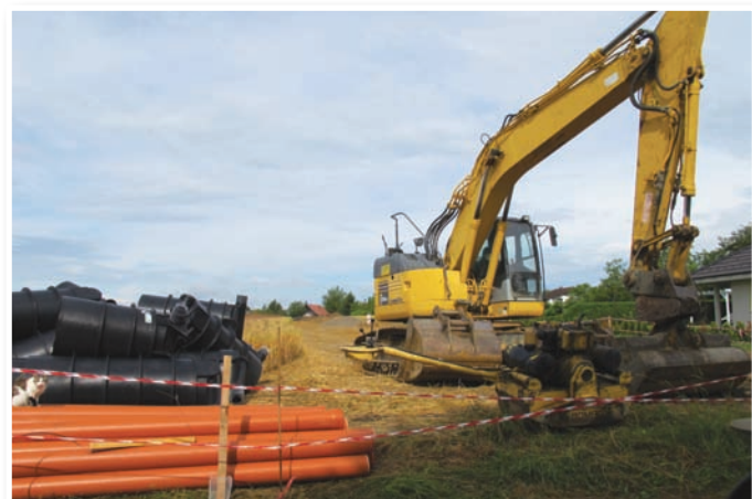
Čez poletje so intenzivno končevali izgradnjo kanalizacije.
