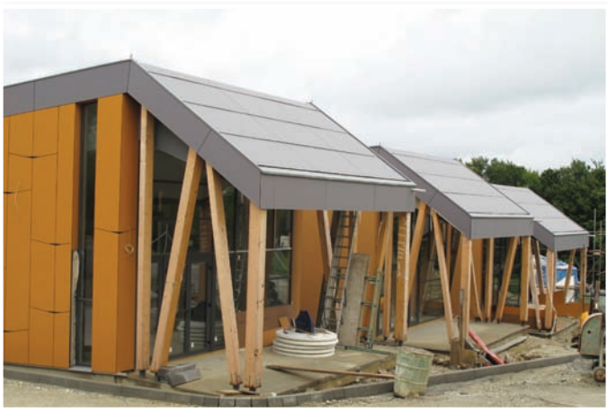
Objekt novega vrtca je zelo atraktiven in bo polepšal vedute Cerkevnikjaka.
