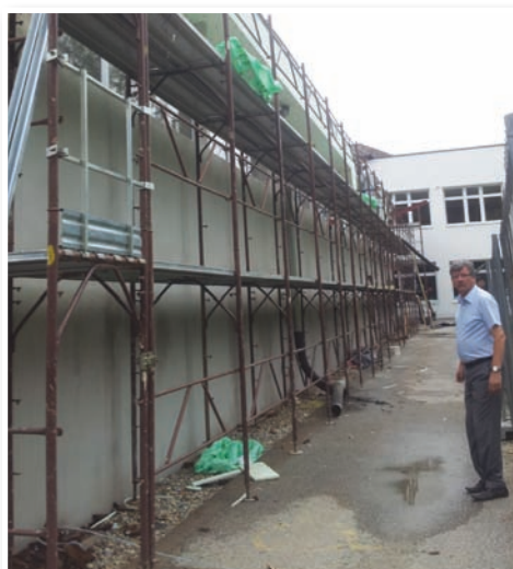
Sredi avgusta je bila okolica šole še gradbišče.
