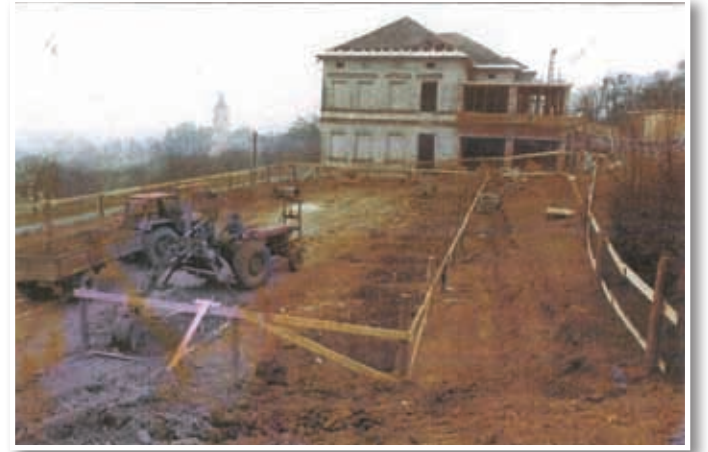
Gradnja telovadnice leta 1978
