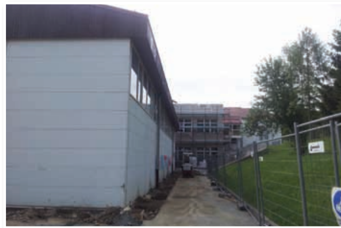
Začetek energetske sanacije telovadnice
