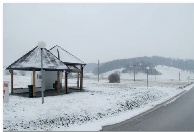
Gradbeno dovoljenje za izgradnjo Term Benedikt na tem zemljišču je že izdano in velja do konca leta 2014.
