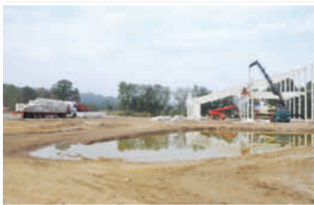
Gradbišče t.i. sončne elektrarne
