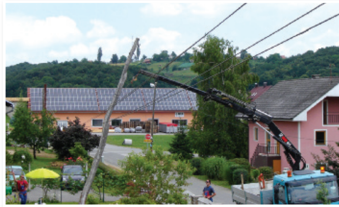
Odstranitev električnih žic in drogov
