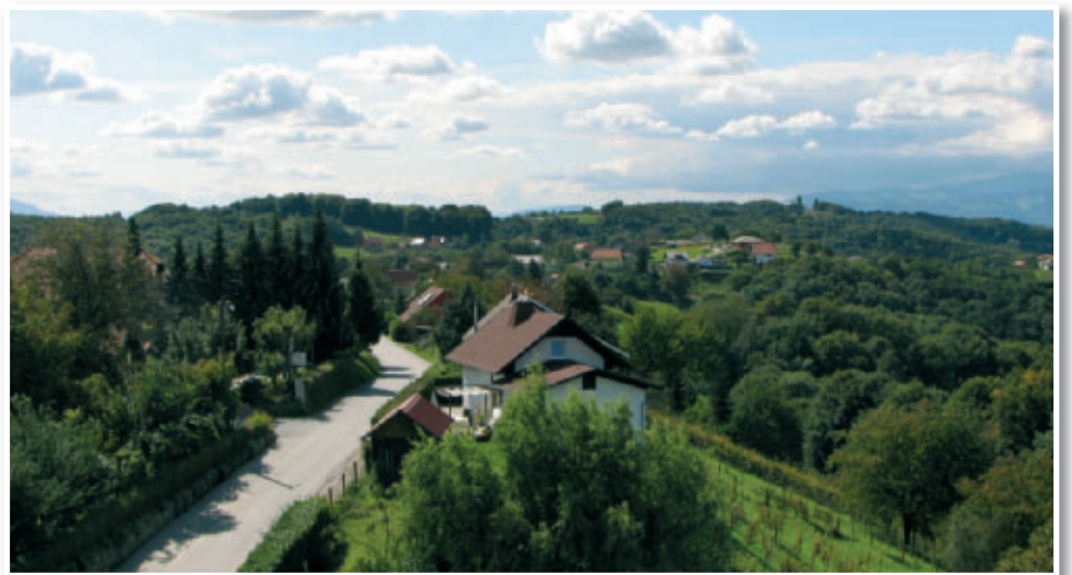
S prenovno ceste in vaškega jedra bo Zavrh poleg urejenosti pridobil veliko tudi na varnosti
