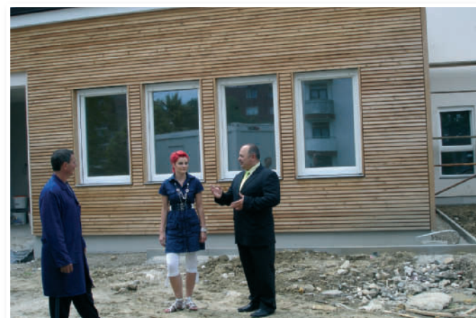
Župan pri ogledu gradbišča
