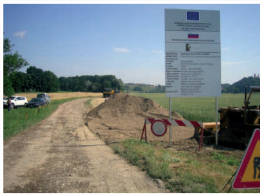
Začetek modernizacije ceste Sp. Porčič - Zg. Senarska
