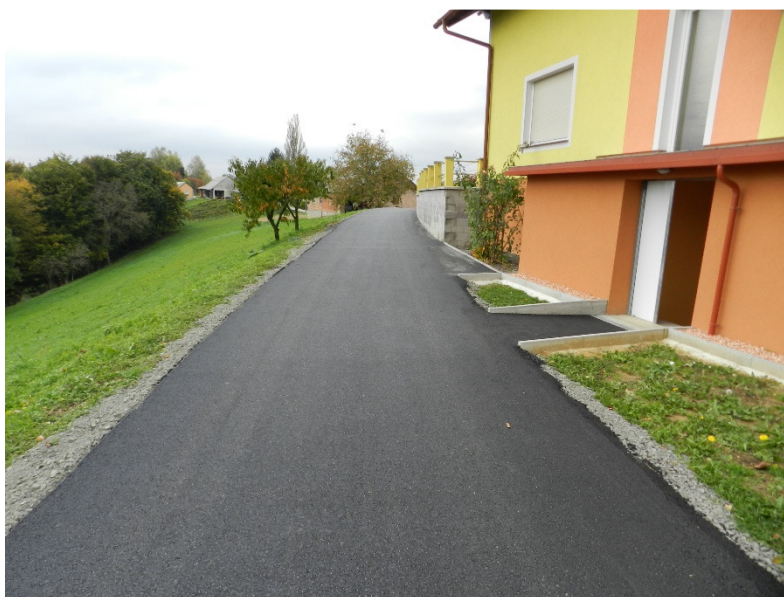
Slika 32: Na novo asfaltirana JP 703 318
