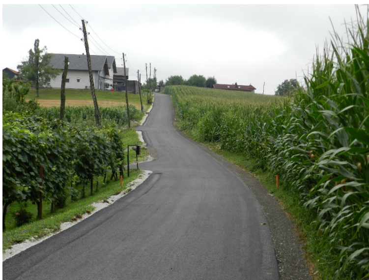
Slika 35: Asfaltirano cestišče na JP 703 341 Zg. Partinje – Široko
