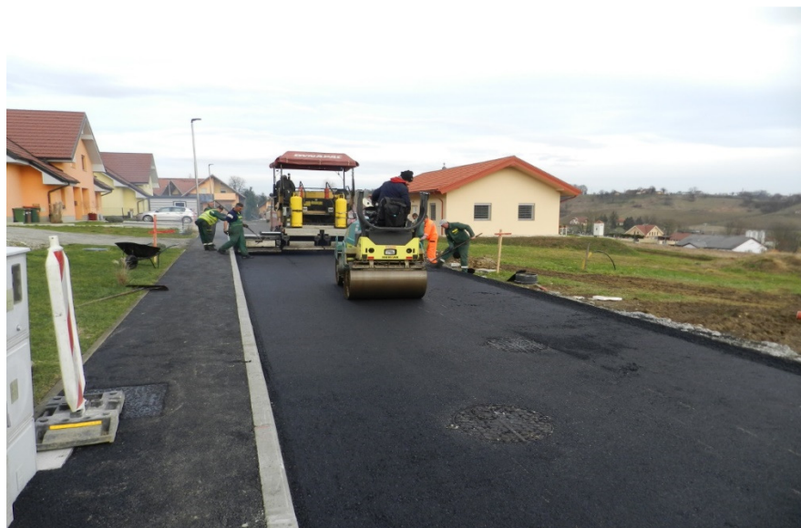
Slika 10: Asfaltiranje JP 703 423 – Sončna soseska
