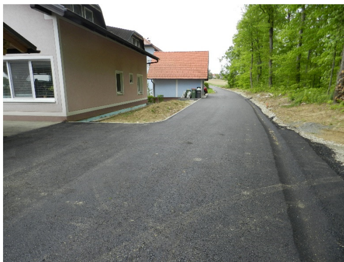
Slika 34: Asfaltirana cesta JP 703 407 Zg. Partinje – Najdenik
