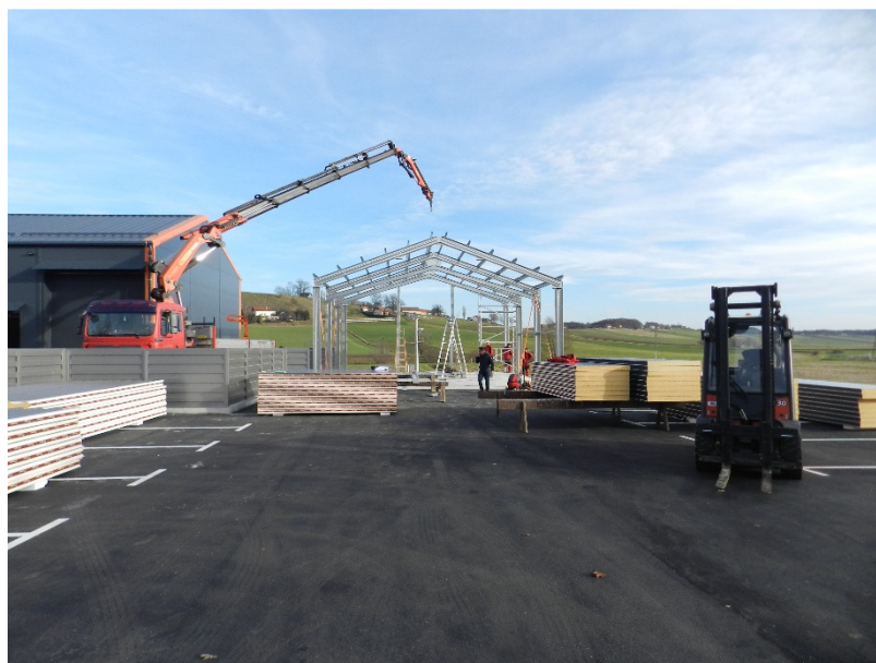
Slika 31: Izgradnja montažnega poslovnega objekta
