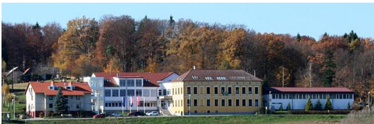
Slika 1: Stavba OŠ Jožeta Hudalesa Jurovski Dol
