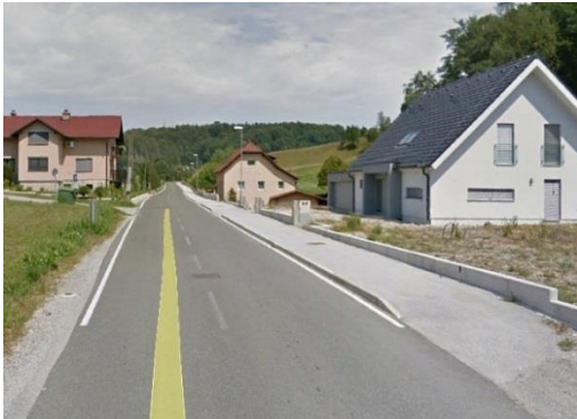
Slika 1: Začetek kolesarske poti, za železniškim prehodom Štrihovec.
