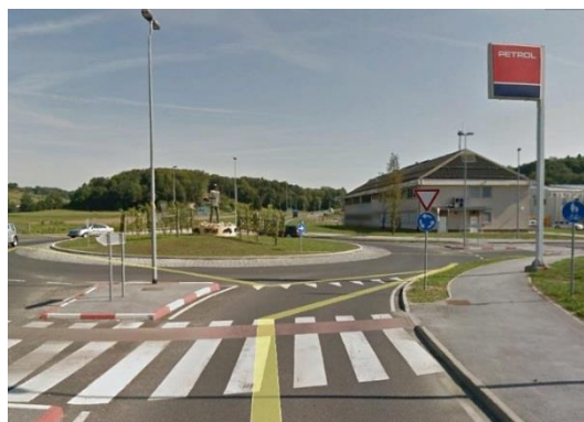
Slika 1: Krožišče v Lenartu, urejena kolesarska steza, R2-449/0315
