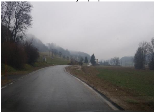
Slika 5: Obnovljen odsek lokalne ceste iz naselja Jarenina proti MB.
