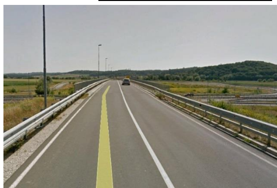
Slika 1: Nadvoz čez AC na regionalni R2-229/1286, brez potrebne širine za ločen promet kolesarjev.
