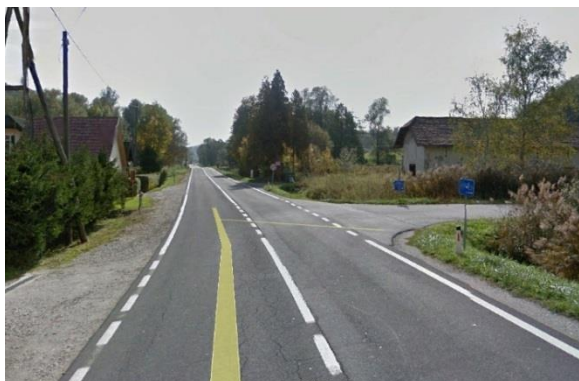
Slika 3: Križišče, kjer se naveže lokalna cesta desno. V nadaljevanju regionalne ceste križanje z železnico (zapornice).
