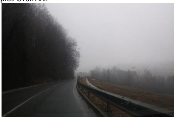
Slika 3: Oporni zid na desni, pred priključkom ceste R3-730/4105.
