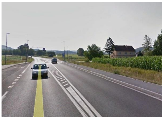
Slika 1: Priključek desno na lokalno cesto v Peklju proti Dragučovi.
