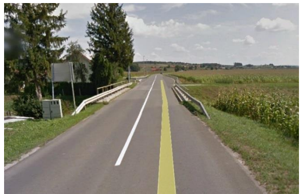
Slika 2: Premostitveni objekt pred priključkom »Lenarške obvoznice« na levo.
