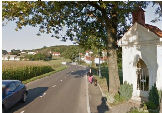
Slika 4: Zaključek pri mostu v Jurovskemu dolu. Cesta ima pločnik za pešce.
