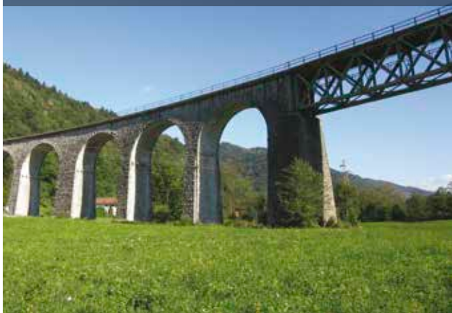
Najdaljši most na bohinjski progi je železniški most Idrijca pred postajo Most na Soči.
